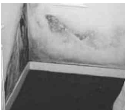
Ściany pokryte czarną pleśnią
